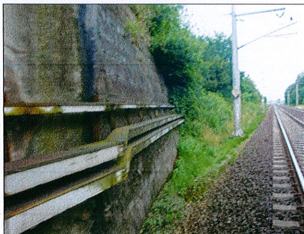
Pohled na stávající žlaby na opěře z trati, budou vyměněny a doplněny
