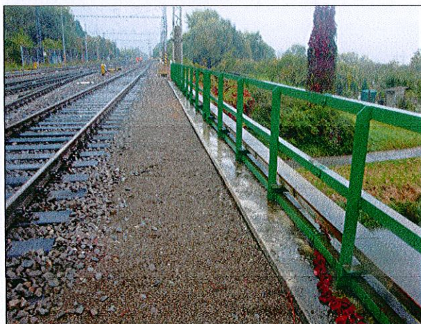
Pohled na most a levou římsu z trati, žlab bude ponechán
