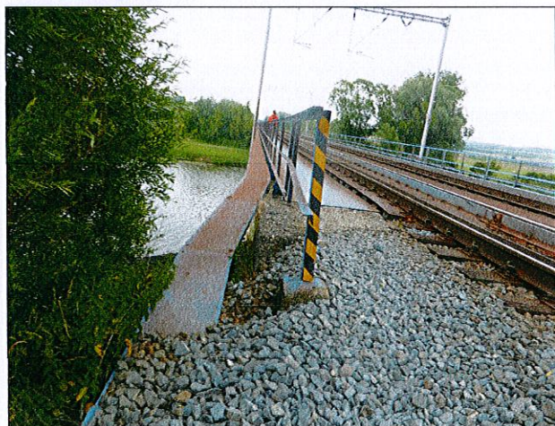
Pohled na "levou" římsu se zábradlím a přechody do trati
