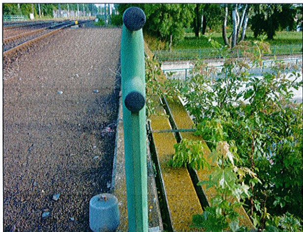
Pohled z trati na "pravou římsu", žlaby budou vyměněny za nové
